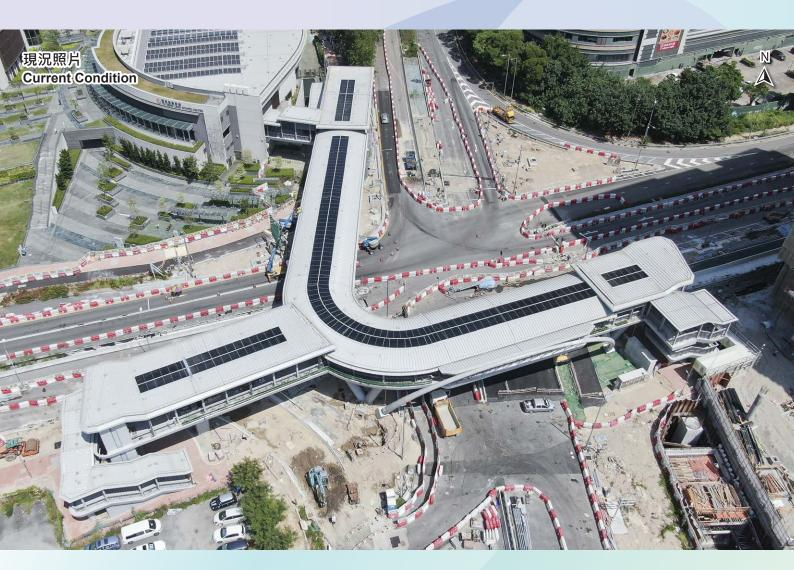
南行人橋的鋼鐵蓋頂安裝以及升降機安裝和相關的測試已大致完成。餘下進行中的工程包括安裝裝飾天花板和行人橋路面的鋪設工作。
